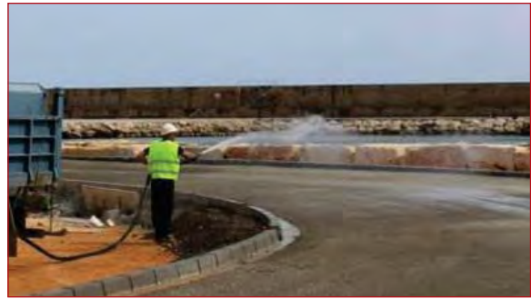
Figura 8.57. Curado del hormigón.
