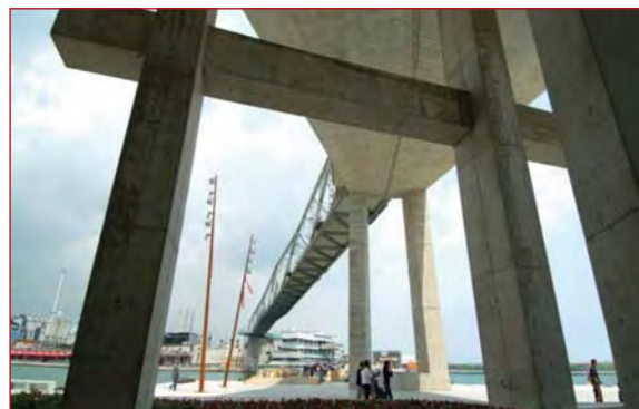
Figura 8.78. Pasarela Fórum de Barcelona.
