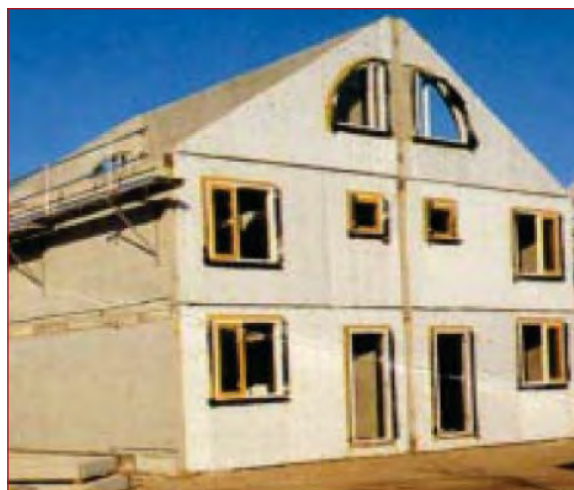
Figura 11. Vivienda construida con paredes prefabricadas de hormigón reciclado.
