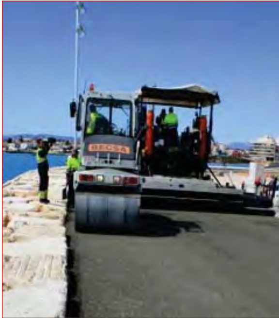
Figura 8.55. Compactador tándem 9.500 kg.
