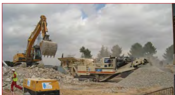
Figura 7.7. Elaboración en obra del árido reciclado para relleno en ampliación de Línea 9 del Metro de Madrid (OB P9.1).
