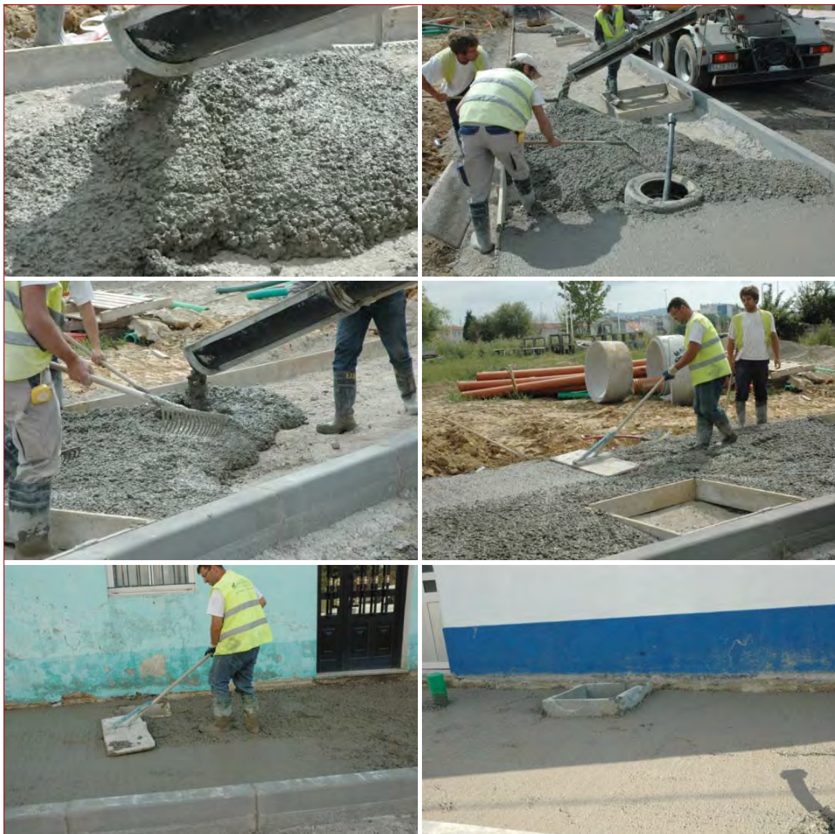
Figura 8.79. Proceso de ejecución.
