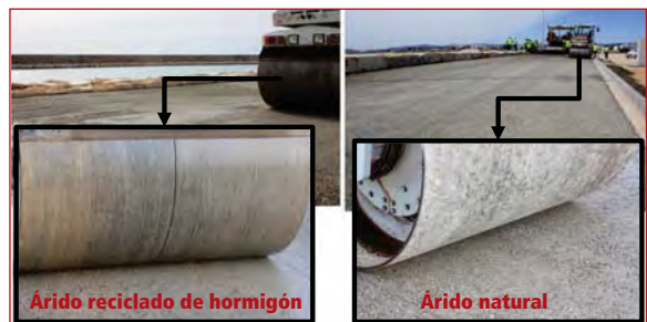
Figura 8.58. Aspecto del hormigón durante la compactación.
