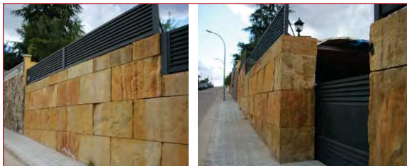
Figura 8.2. Bloques GDP empleados en la construcción del muro de una vivienda unifamiliar.
