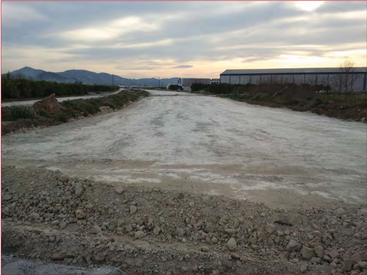
Figura 7.22. Estado actual de las obras.
