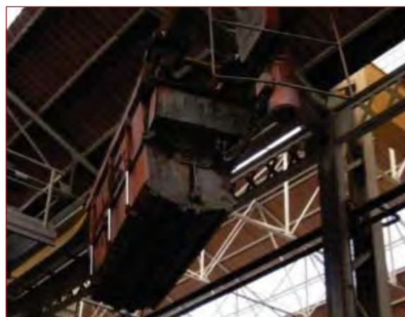
Figura 8.14. Transporte del hormigón fresco a la tolva de la moldeadora.
