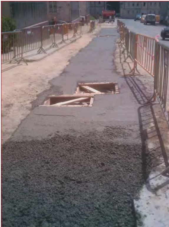
Figura 8.83. Hormigón realizado con gravilla mixta.
