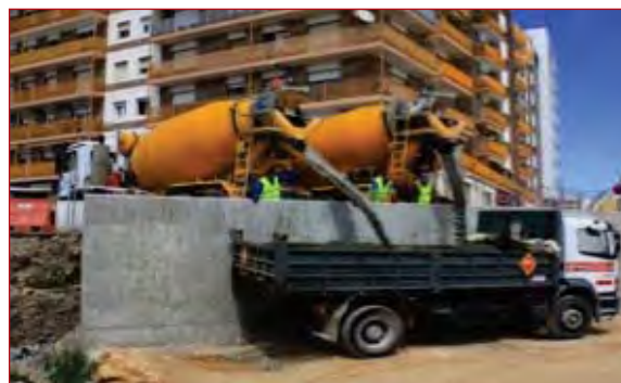
Figura 8.53. Muelle de descarga.
