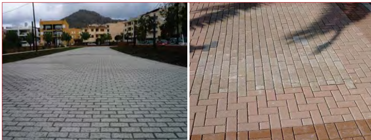
Figura 8.26. Tramo de pavimento realizado con adoquines fabricados a partir de áridos reciclados.
