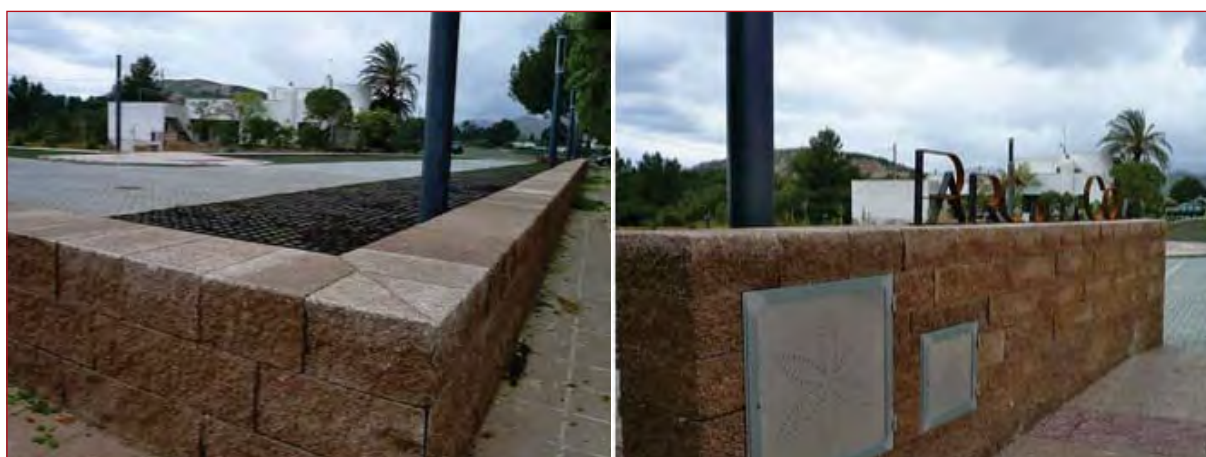
Figura 8.27. Muro construido a partir de bloques prefabricados con áridos reciclados.
