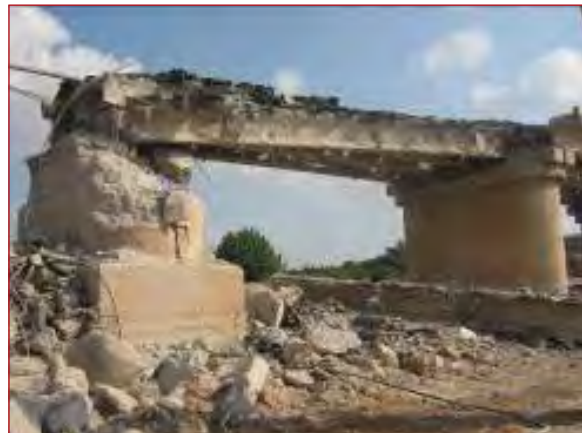
Figura 8.74. Demolición selectiva.
