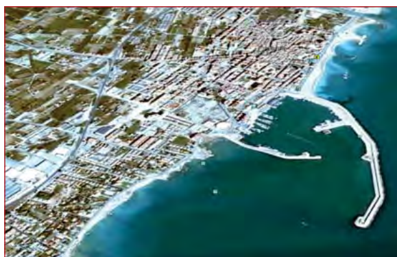
Figura 8.40. Situación de la obra .
