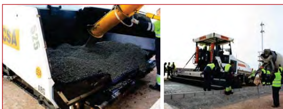
Figura 8.52. Vertido directo desde camión hormigonera a la extendidora.
