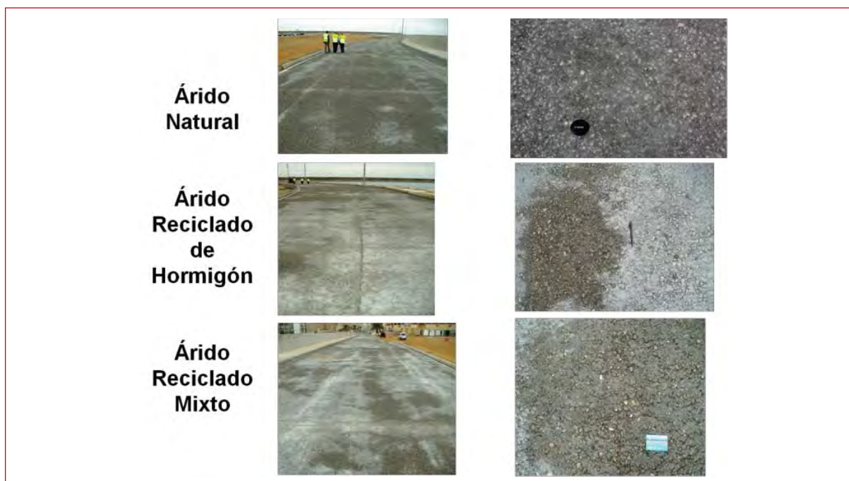
Figura 8.59. Aspectos de los distintos tipos de hormigón tras la compactación.
