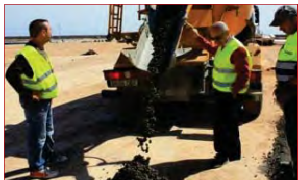
Figura 8.49. Verificación de las dosificaciones.
