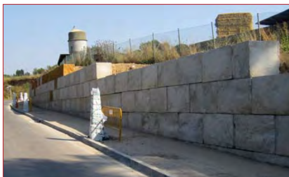
Figura 8.22. Muro construido con bloques prefabricados a partir de áridos reciclados.
