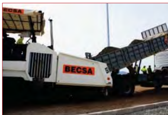
Figura 8.54. Vertido desde camión volquete.
