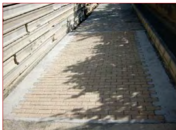
Figura 8.25. Tramo de pavimento piloto realizado con adoquines fabricados a partir de áridos reciclados.
