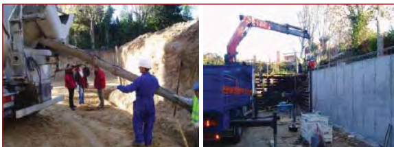
Figura 8.73. Puesta en obra del hormigón.
