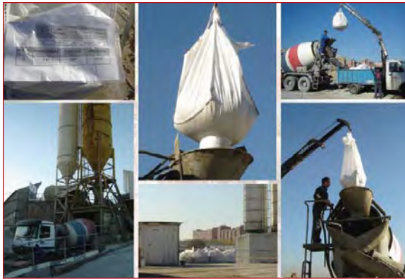
Figura 8.72. Fabricación del hormigón en central.
