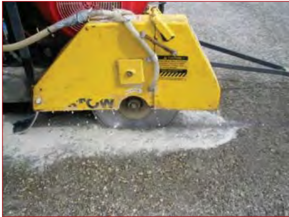
Figura 8.61. Corte de juntas.
