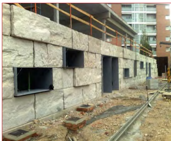
Figura 8.24. Muro construido con bloques prefabricados a partir de áridos reciclados.
