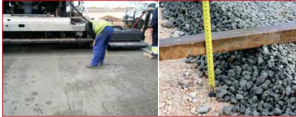
Figura 8.45. Medición del descenso tras la compactación del tramo de prueba.
